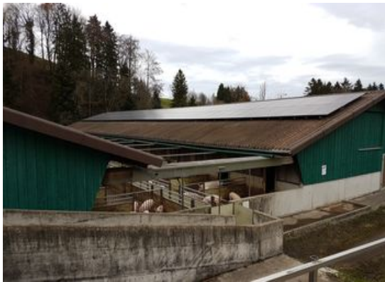
Aufdach-Photovoltaikanlage auf landwirtschaftlichem Gebäude. In der Regel dem Meldeverfahren unterstellt, da weniger als 20 cm über der Dachfläche (© MBRsolar AG)
