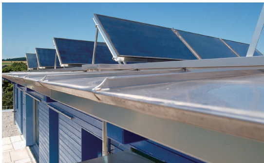
Solarwärme-Aufdachanlage auf Flachdach, um mehr als 20 cm aufgeständert. Ordentliche Baubewilligung erforderlich, sofern der Geltungsbereich des Meldeverfahrens vom Kanton nicht ausgedehnt wird. © Swissolar
